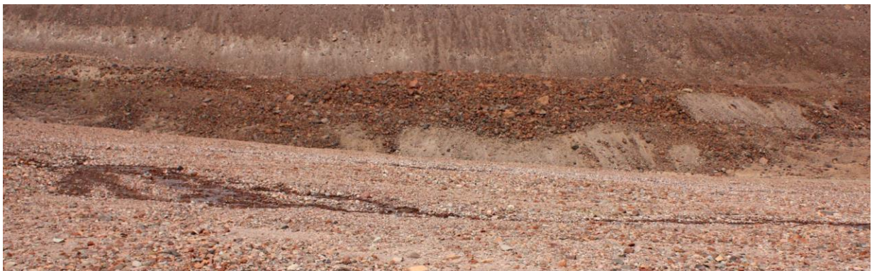
Vista oeste de la geoforma
